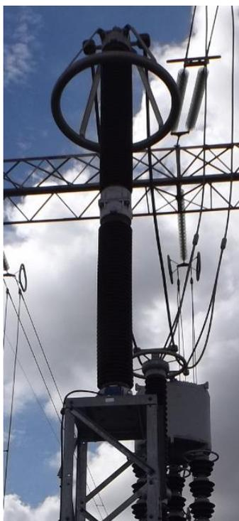
Figura 3.3 – Foto de um dos PRs de 345 kV medidos em campo
