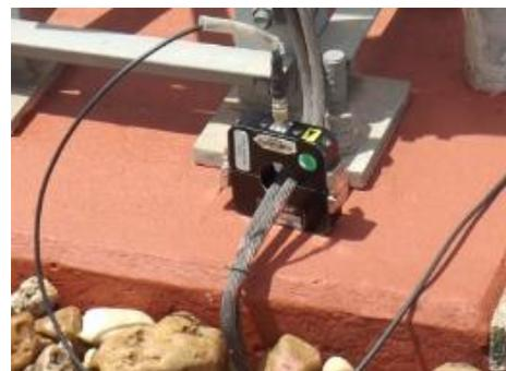
Figura 3.8 – Exemplo de um TCAF conectado ao cabo de aterramento do equipamento
