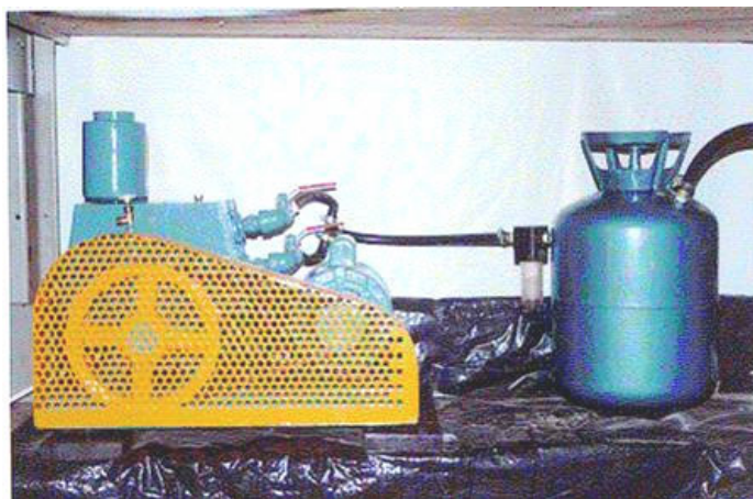
Figura 13: Sistema bomba de vácuo-recipiente de armazenamento
