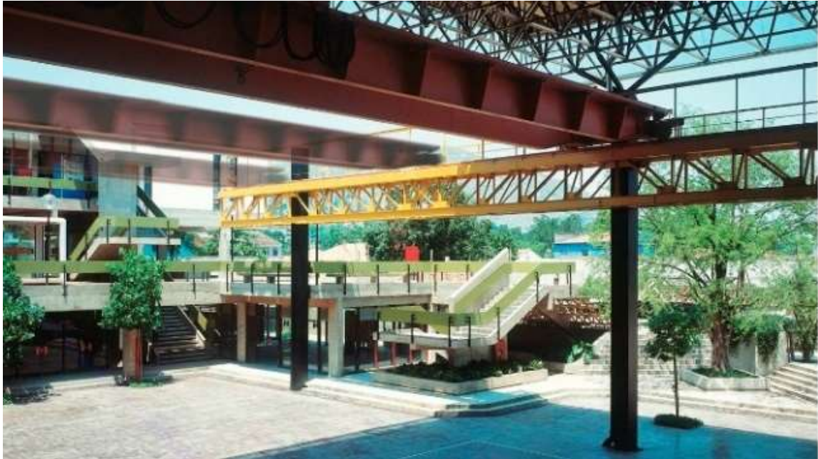
Espaço multiuso com Ponte Rolante
