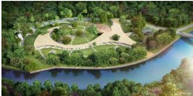
Vista aérea do Centro Cultural Caborê
