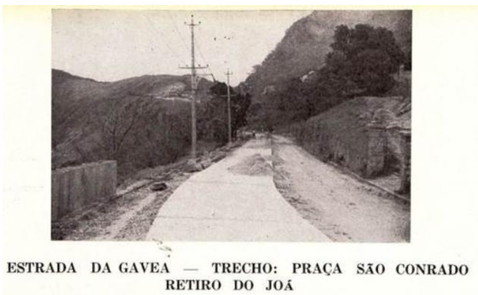
Figura 18- Fotografia das obras de pavimentação da Estrada da Gávea ( Revista Municipal de Engenharia , janeiro de 1940, número 1, volume VII).
