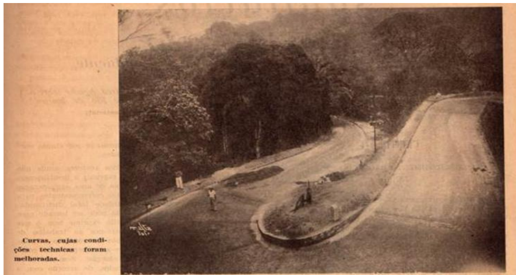
Figura 14- Fotografia das obras de pavimentação na Estrada da Gávea ( Revista Municipal de Engenharia , setembro de 1934, número 12, ano III).
