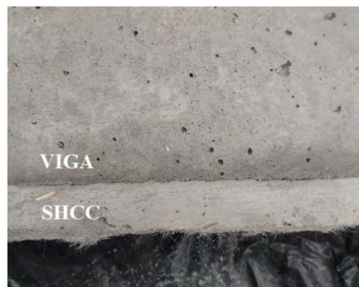
Figura 44 – Detalhe da interface entre a viga e a camada de reparo.
