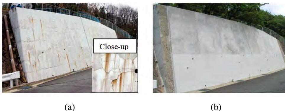
Figura 9 - Muro de Contenção localizado na região de Gifu, Japão: (a) fissurado e (b) reparado com camada de SHCC [132].
