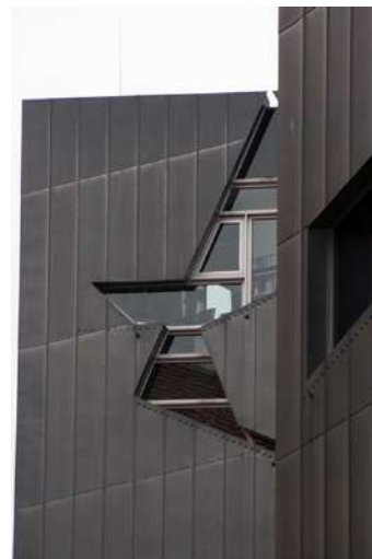
Figure 19 | revestimento em zinco / aberturas . Museu Judaico de Berlim Foto: Francisco Palmeira de Lucena
