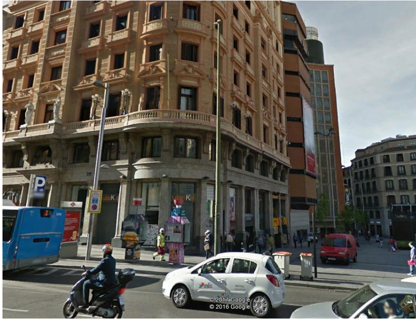
Figura 3.10 – Postes em Madri. Fonte: Google Earth.
