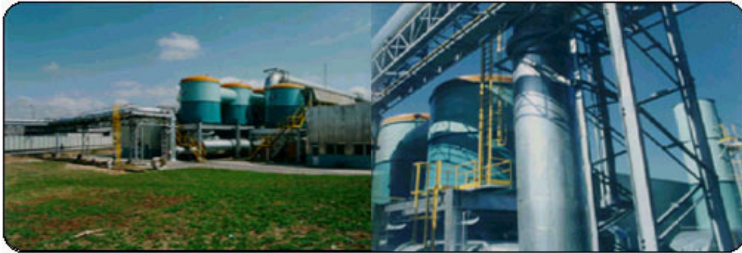
Figura 16 – Fotos da estação de controle de emissões atmosféricas.
