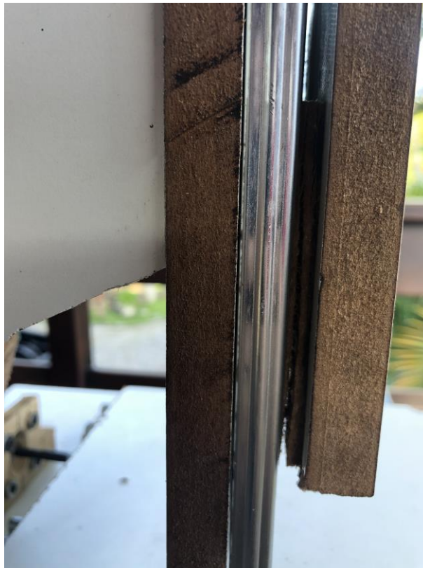
Figura 33: Rachadura na madeira
