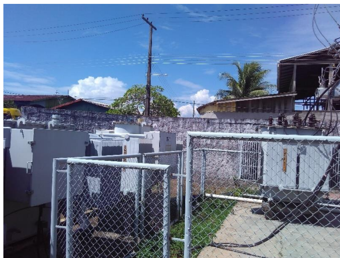
Figura 18 - Casas próximas à usina de Careiro da Várzea - AM Fonte: Arquivo pessoal
