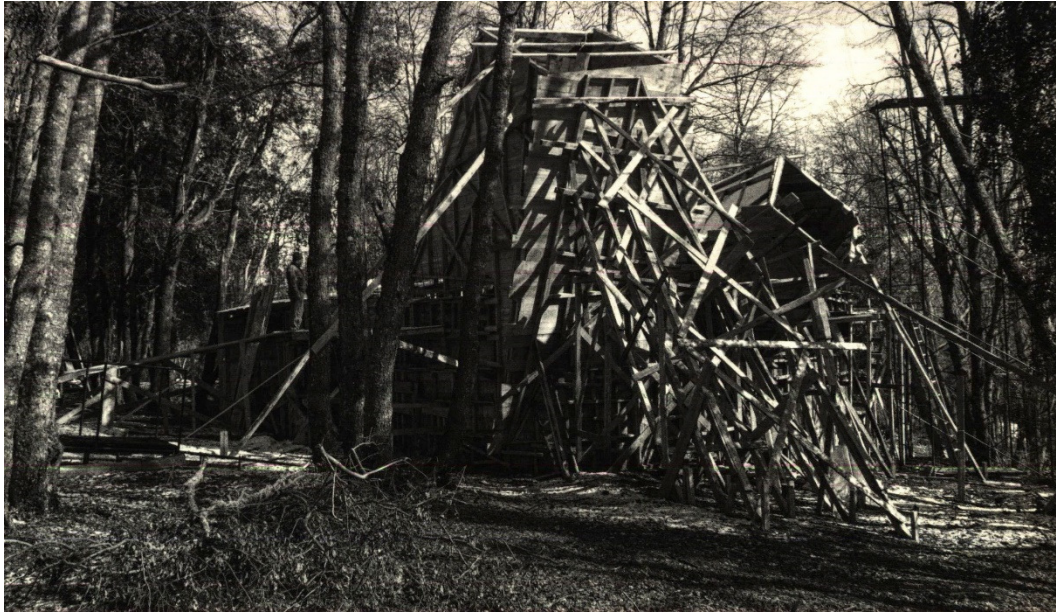
Figura 87: Casa para El Poema del Ángulo Recto: Construção. Fotografia: Smiljan Radić. Fonte : RADIC. S., Obra Gruesa , p. 191.
