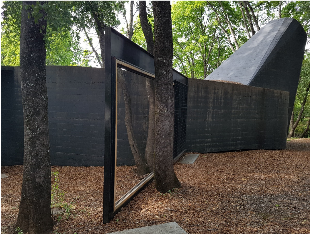
Figura 93: Casa para El Poema del Ángulo Recto: detalhe da estrutura metálica. Fonte: o autor.
