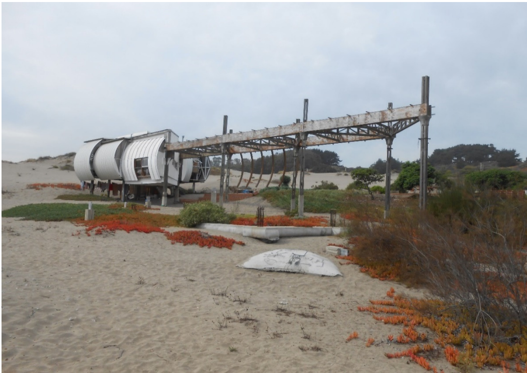
Figura 4: Hospedaria del taller de obras: Ciudad Abierta. Año 2015. Fonte: o autor.
