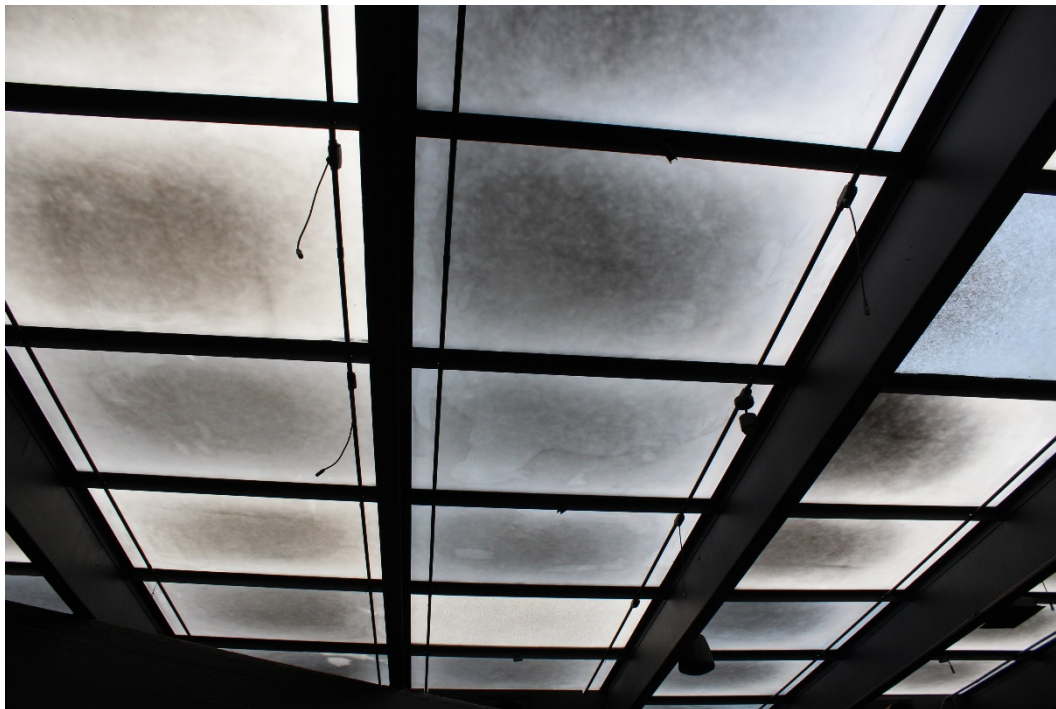
Figura 51: Restaurante Mestizo: placas de vidro da cobertura. Fonte: o autor.
