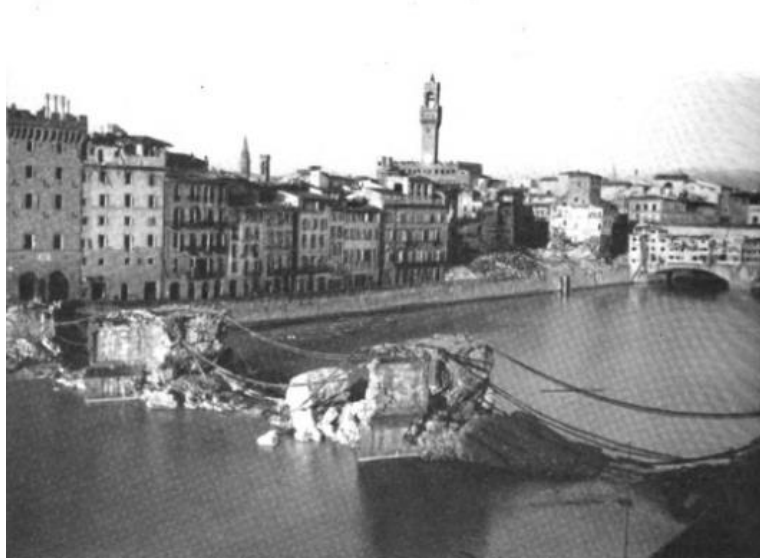
Figura 5: Florença, Itália. Pontes e casas destruídas.
