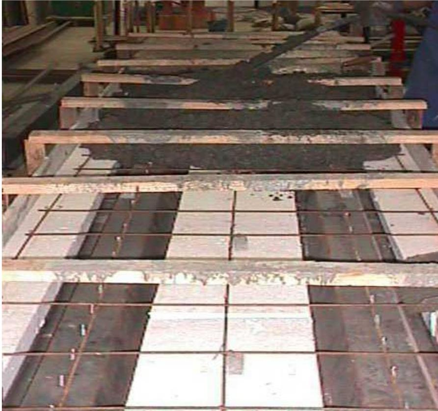
Figura 1.5 – Sistema com perfil metálico e isopor [1].
