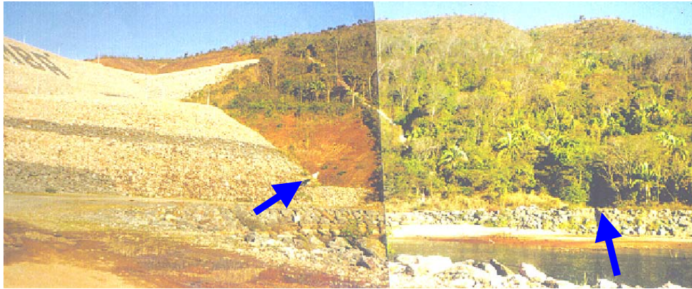
Figura 3.8 Visão da ombreira esquerda, com as setas indicando a posição das surgências d'água. (Furnas relatório de visita à obra N° 091, 1997).
