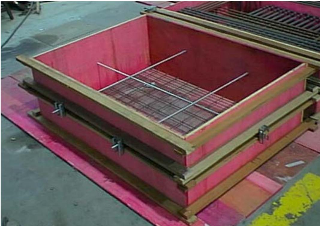
Figura 3.5 - Detalhe da fôrma de um bloco B4, mostrando as barras de reforço.
