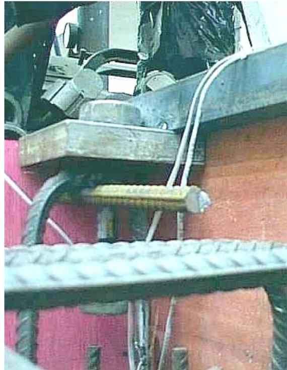
Figura 3.8 - Detalhe da armadura de suspensão usada em placa de canto e de bordo e o posicionamento na fôrma.
