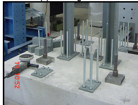
(d) sapata concluída
