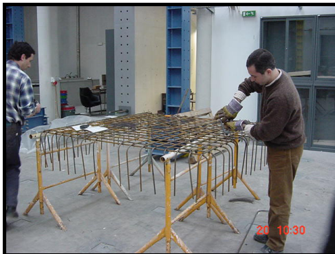
(a) confecção da armadura
