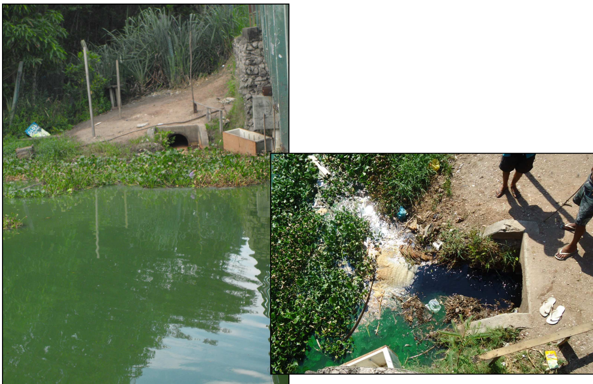
Apêndice II 11 – Saída de uma tubulação na Lagoa de Jacarepaguá. Detalhe para a cor escura do líquido que saía da mesma.
