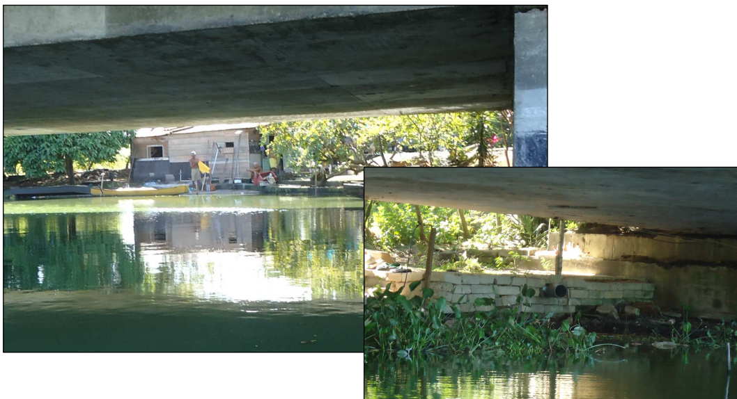
Apêndice II 3 – Casa localizada à margem do Rio Marinho. Detalhe para a saída de uma tubulação ao lado desta casa na Lagoa de Jacarepaguá.
