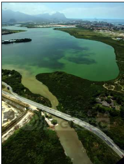
(a) Vista W-E, ponte sobre o Rio Marinho (SOS Rios do Brasil, 2008).
