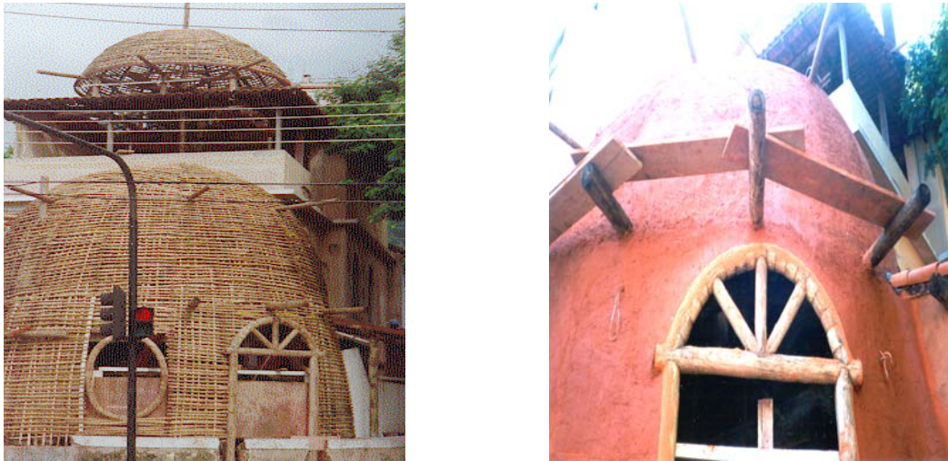
Figura 1.6. Vista frontal da Boate Cozumel na Lagoa em fase de construção e revestimento com barro.
