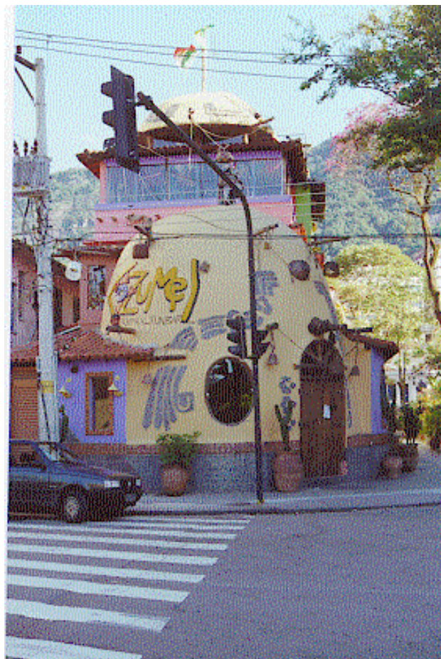
Figura 1.7. Vista frontal da Boate Cozumel concluída.
