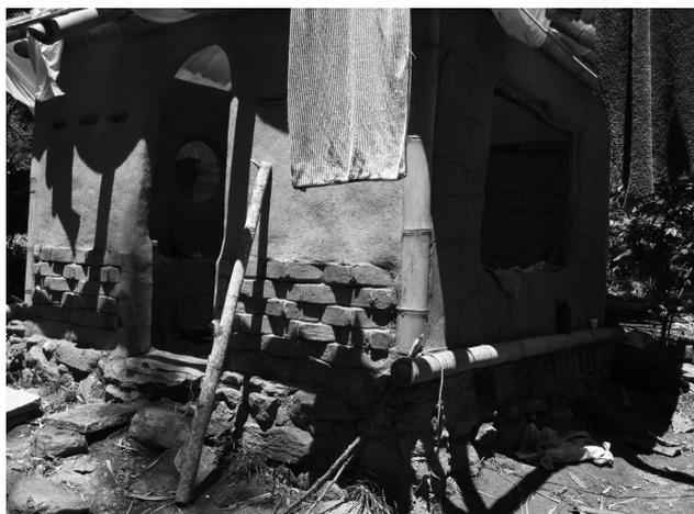
Fig. 07. Construção com base de pedra, camada de tijolos de adobe e taipa de mão por cima, localizada no Tibá, RJ
