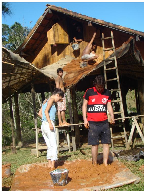
Fig. 12. Pisoteio do barro para aplicação em cobertura em forma de paraboloides
