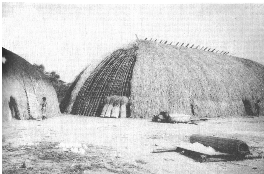
Fig. 05. Casa dos índios Kamayurá em construção (Fonte: Ribeiro, 1987, p. 53)
