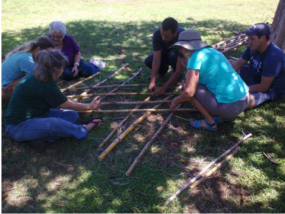
Fig. 106: Amarrações sendo feitas na treliça
