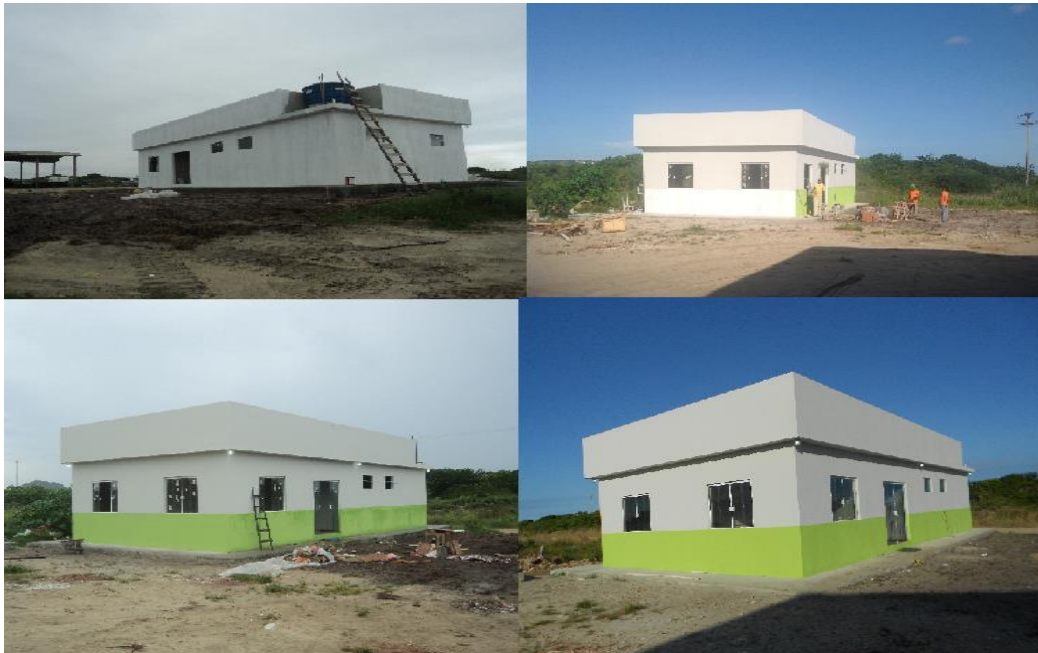
Figura 26: Construção do Prédio Administrativo da Usina de Reciclagem em Arraial do Cabo.
