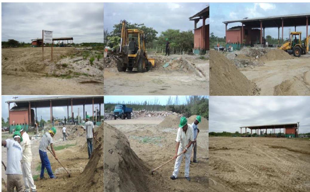
Figura 23: Início das obras de reforma e ampliação da Usina de Reciclagem.
