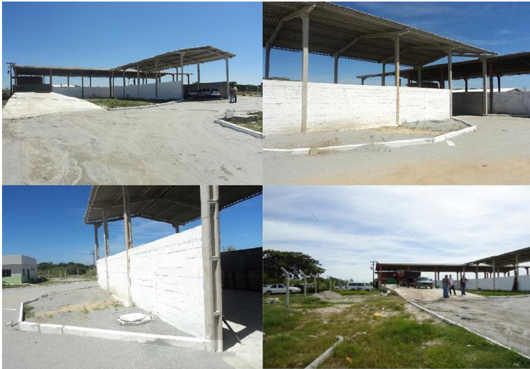
Figura 30: Rampa de Acesso ao Galpão de Triagem e o Galpão de Reciclagem de Resíduos da Construção Civil da Usina de Reciclagem em Arraial do Cabo.
