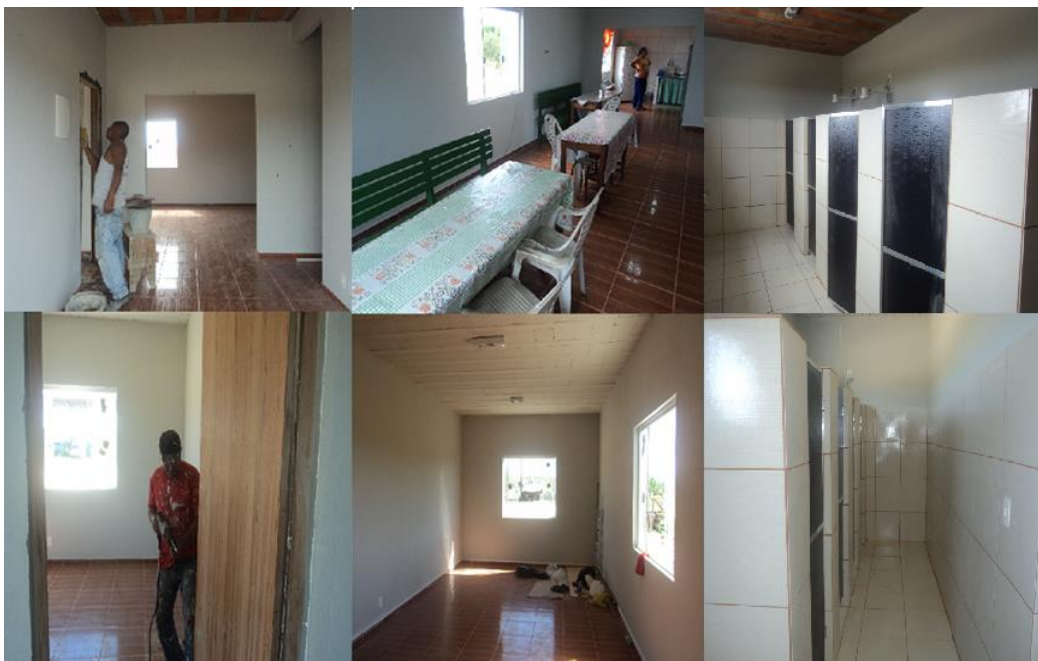
Figura 27: Construção do Prédio Administrativo em Arraial do Cabo.
