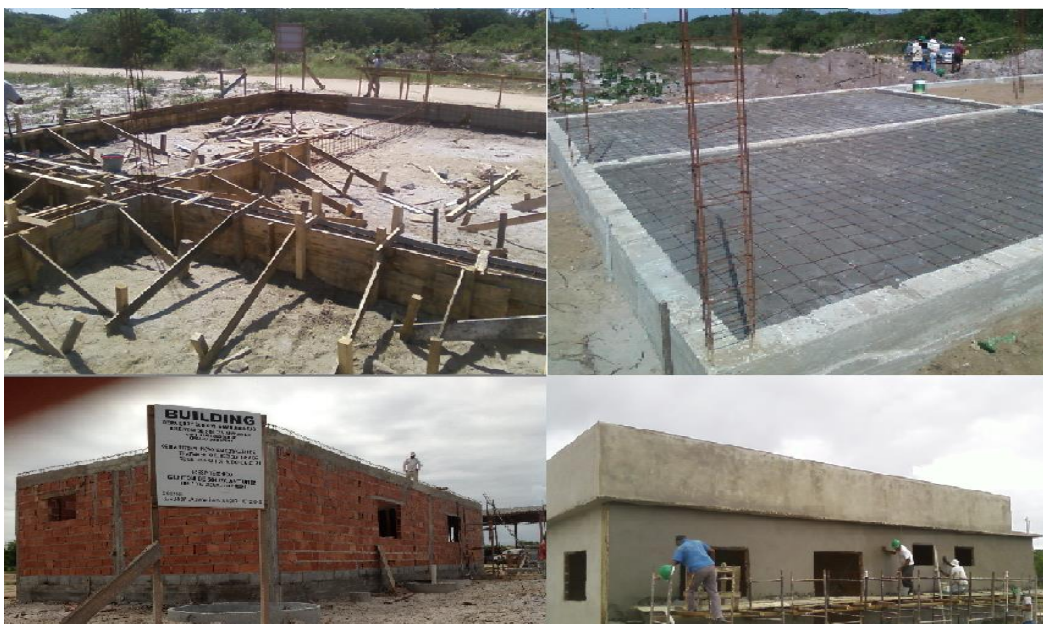
Figura 24: Construção do Prédio Administrativo.
