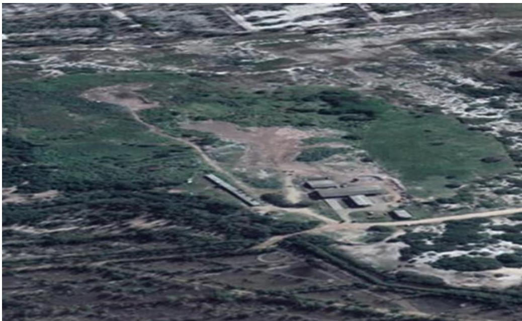
Figura 18: Foto aérea da Usina de Reciclagem.
