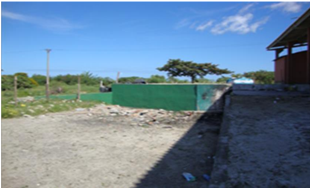
Figura 16: Rampa para recepção dos caminhões em precárias condições.
