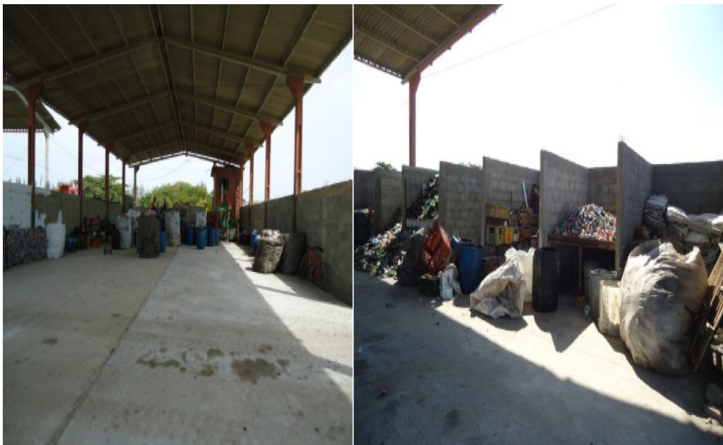
Figura 31: Galpão de Triagem da Usina de Reciclagem.
