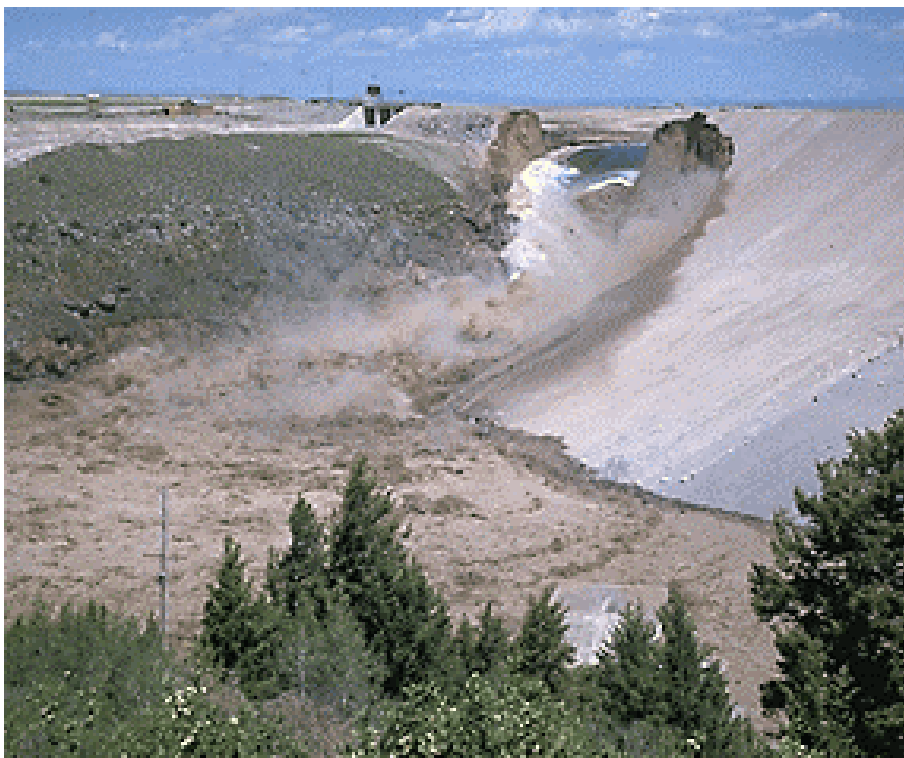
Figura 10 - Ruptura da Barragem de Teton – Estados Unidos (USBR, 2003)
