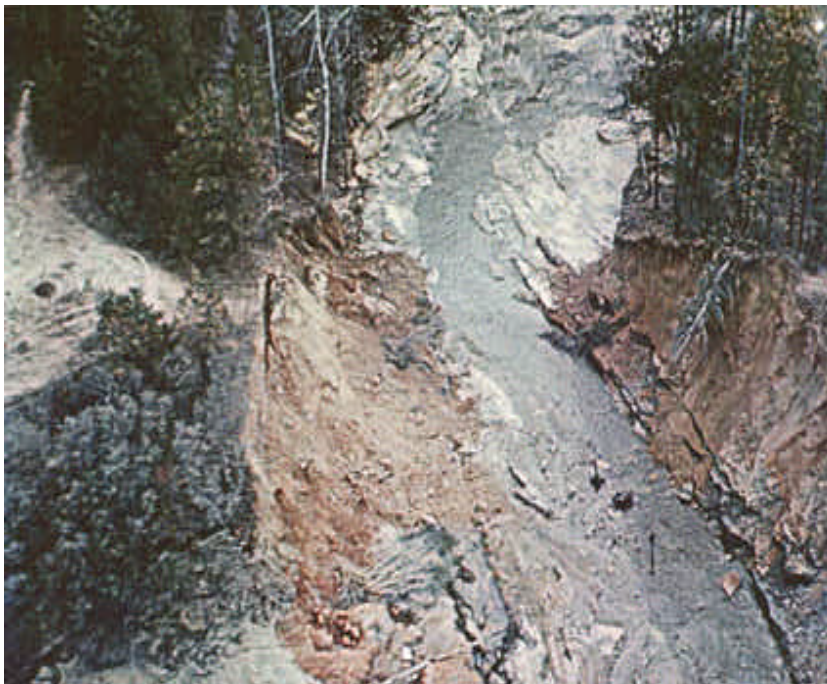
Figura 12 - Ruptura da barragem de Kelle Barnes (USGS, 2003)
