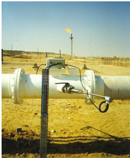
Figura 2 – Medidor Ultrassônico de Gás de Flare (PINHEIRO, 2010)
