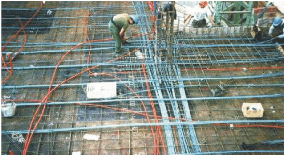
Figura 2.8 – Execução da protensão de uma laje [4].
