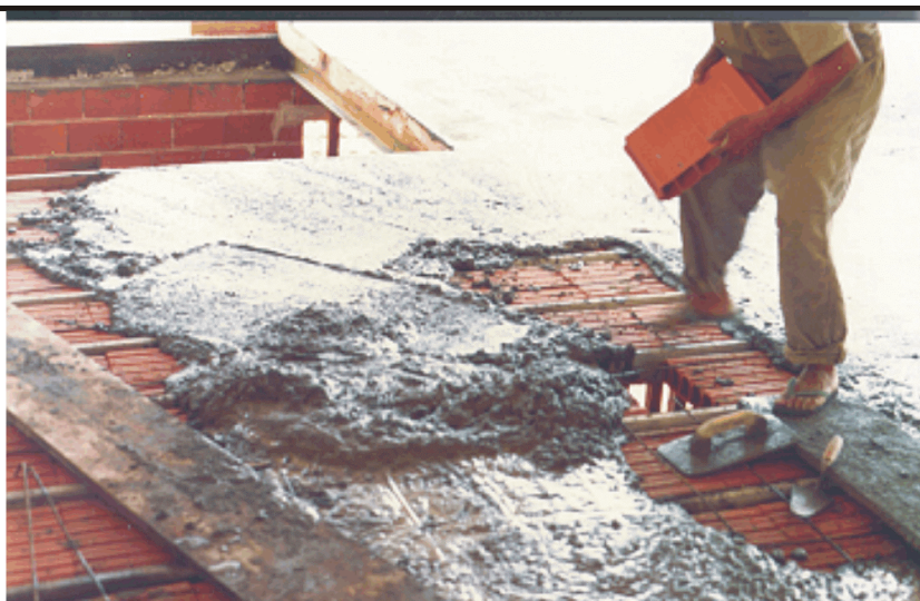
Figura 2.3 – Concretagem de uma laje pré-moldada com blocos cerâmicos.
