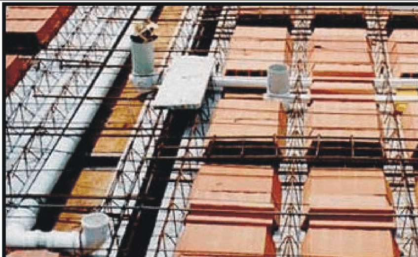
Figura 2.5 – Laje treliçada com enchimento de cerâmica [3].
