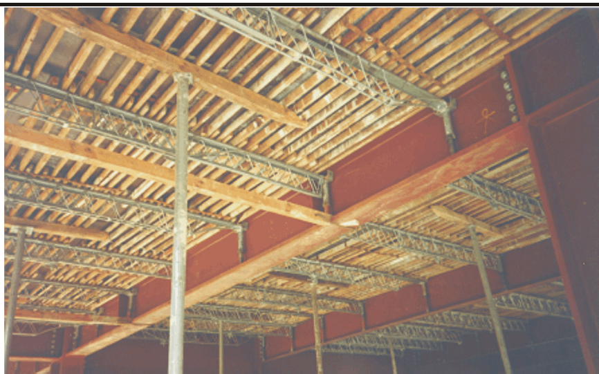
Figura 2.1 – Detalhe das escoras e fôrmas para uma laje maciça.
