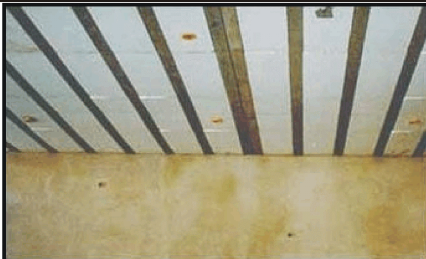
Figura 2.6 – Laje treliçada com enchimento de isopor [3].
