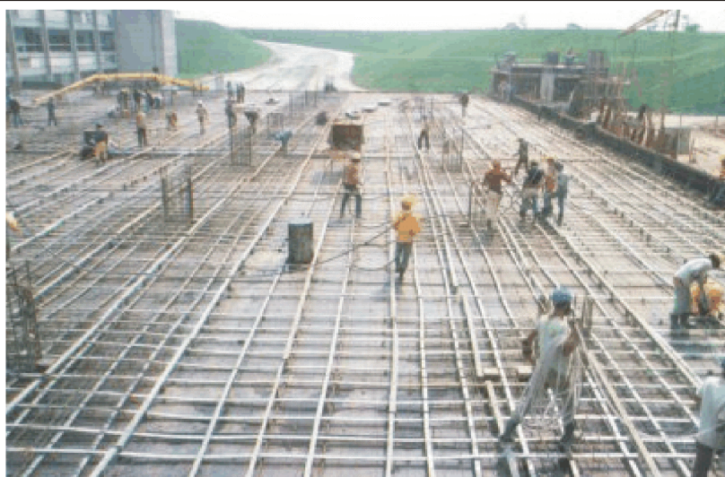
Figura 2.7 – Execução de uma laje protendida [4]
