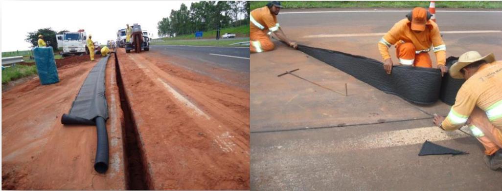
**Figura 5.9 Drenagem subsuperficial com geocomposto como trincheira drenante**
