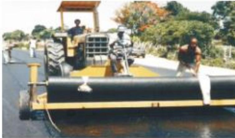
**Figura 2.11 Aplicação de geossintético sobre a capa antiga, já imprimada com asfalto através de suporte rodante**
