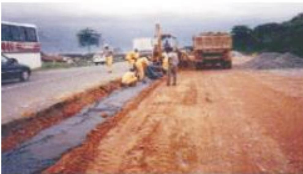
**Figura 2.17 Dreno de pavimento rodoviário construído junto com a estrada**
