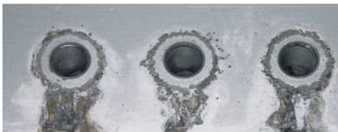
Figura 21 - Exemplo da formação de corrosão galvânica em uma estrutura de alumínio e aço. (Fonte: http://aluminumsurface.blogspot.com.br/2009/04/corrosion-between-anodized-aluminum-and.html , acessado em 15/09/2013).
