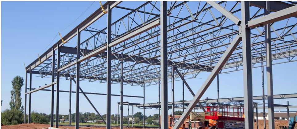
Figura 2.11 – Cobertura com steel joist.
