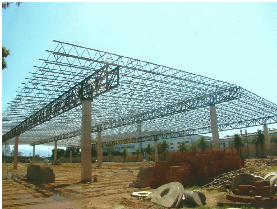
Figura 1.5 – Galpão em construção – Rio de Janeiro.
