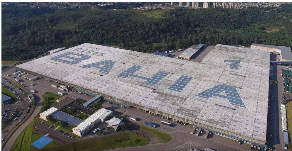
Figura 1.4 – Centro de distribuição das Casas Bahia – Jundiaí.
