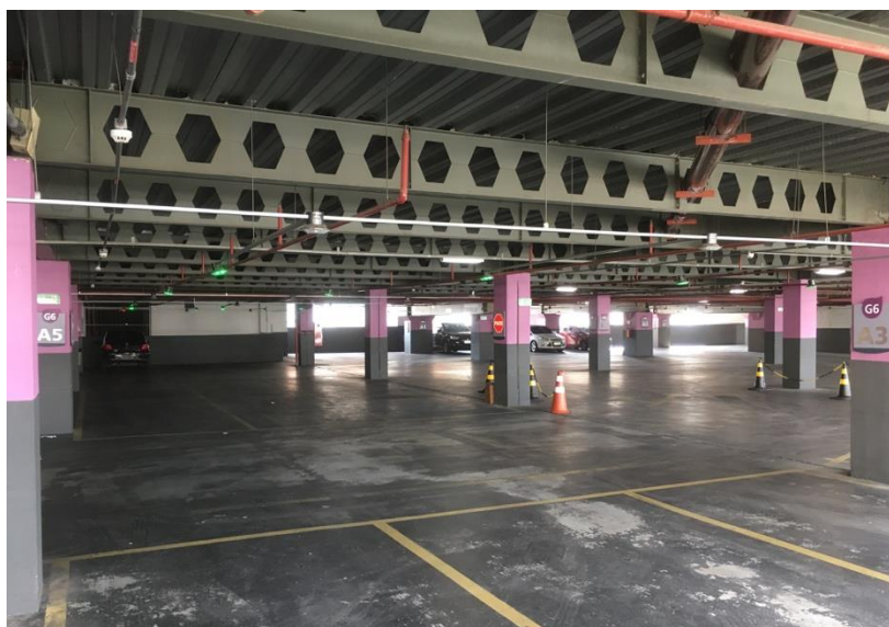
Figura 2.3 – Vigamento do estacionamento do Shopping Tijuca, Rio de Janeiro
