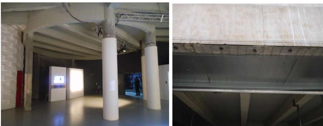
Figura 98 e Figura 99: colunas engordadas para reforçar a estrutura e trama metálica para sustentar o revestimento em mármore existente. Fotos: Laura Rosenbusch.
