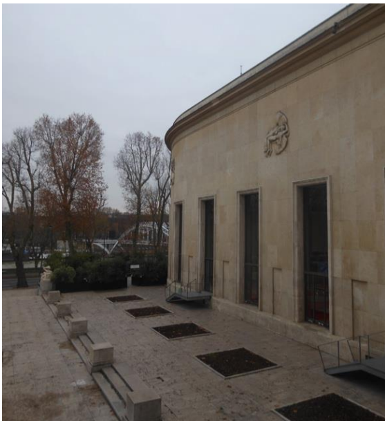
Figura 74: Imagem do exterior do edifício, novos acessos desde o pátio ao nível 1 atualmente desativados. Foto. Laura Rosenbusch.
