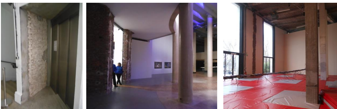
Figuras 100, 101 e 102: Paredes existentes mantidas sem acabamentos. Fotos: Laura Rosenbusch.
