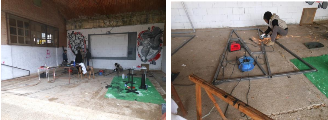
Figuras 109 e 110: Trabalho de recuperação dos armazéns realizado pelos coletivos, entre eles, Recetas Urbanas de Santiago Cirugeda.
