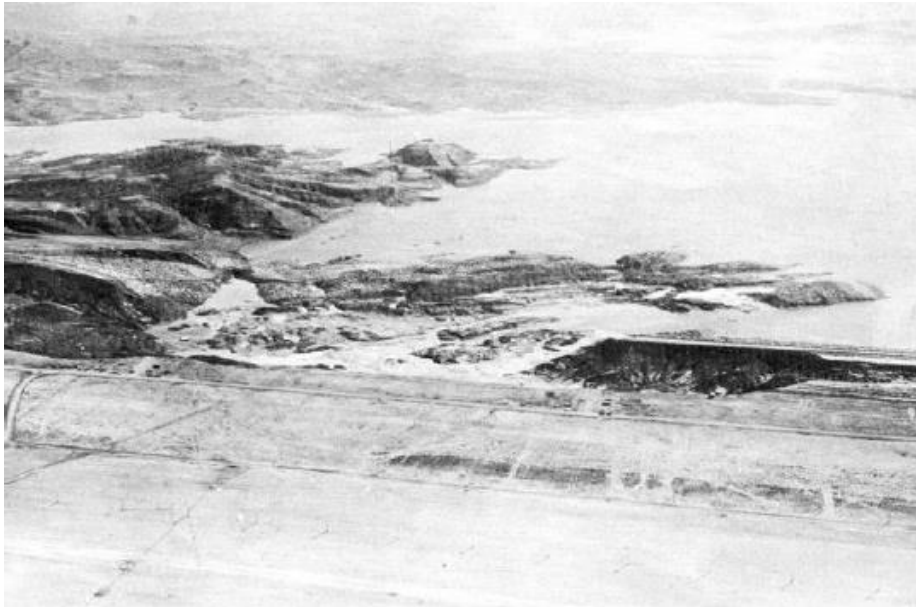
Figura 2.1 - Vista aérea da Ruptura de Fort Peck (Jefferies e Been, 2016)
