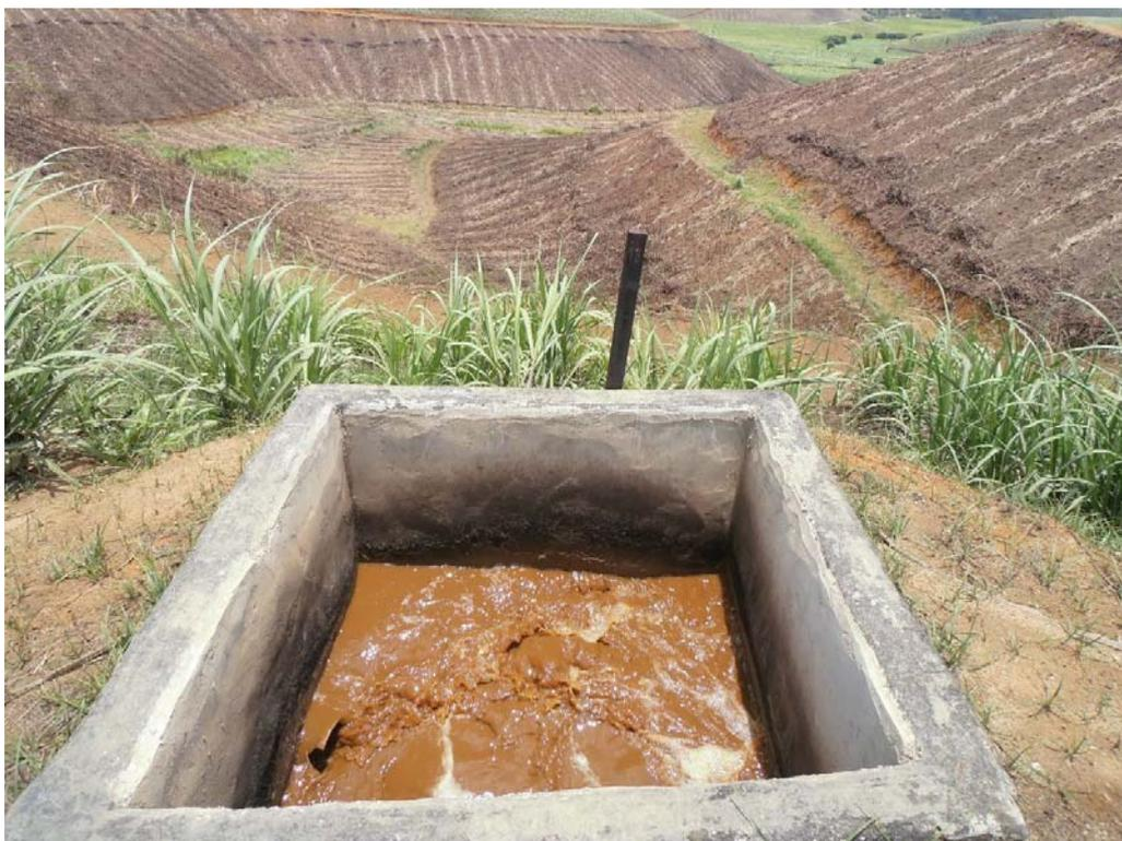
**Figura 22: Poço de verificação de nível do sistema de bombeamento de vinhaça**
