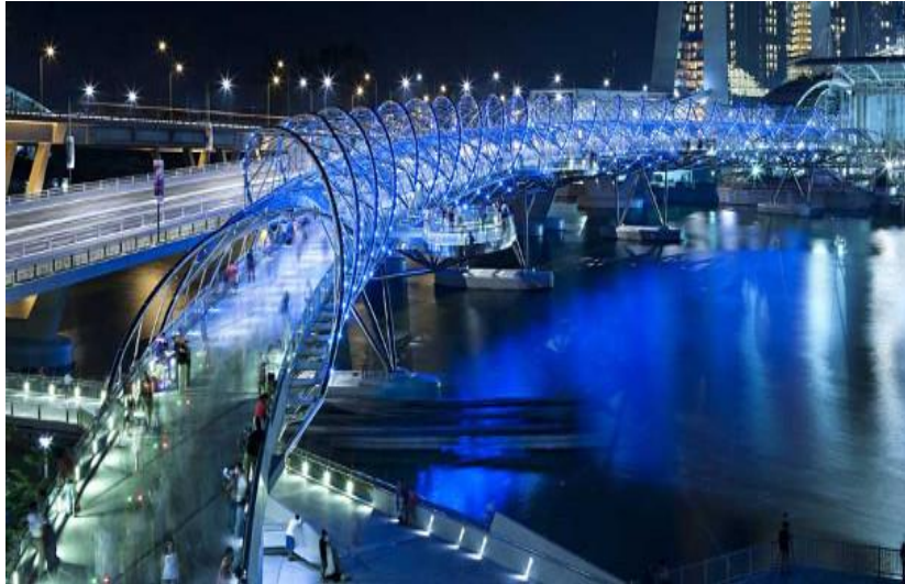
c) Ponte Helix - Cingapura.
