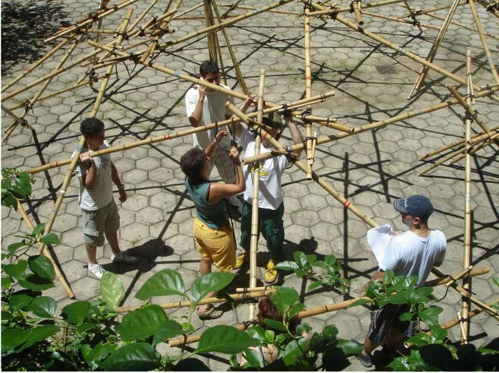
Fig.76 – malha geodésica de bambu atada.
