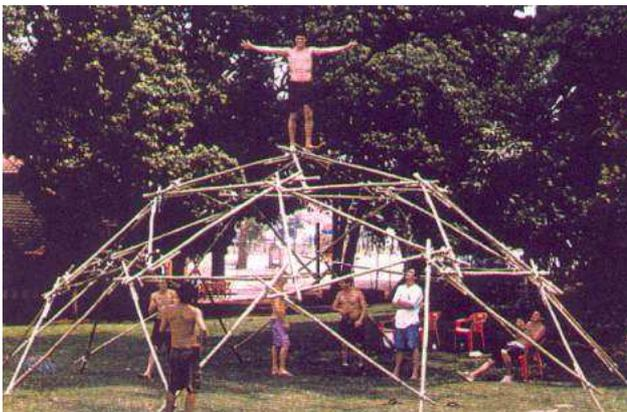
Fig.24 – geodésica de bambu amarrada, Campo Grande, MS.
