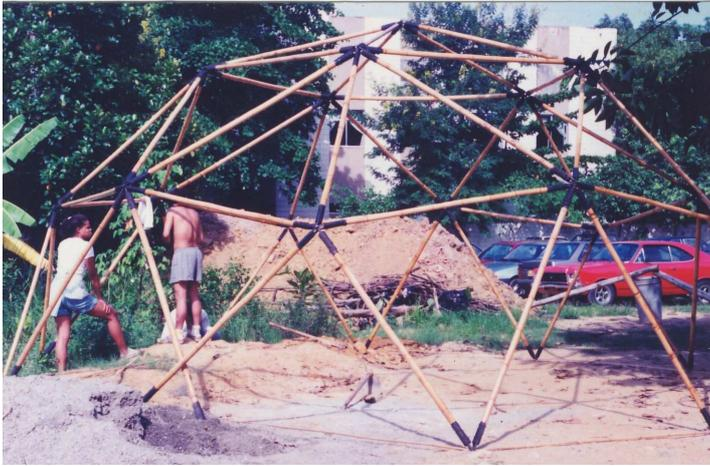
Fig. 11 - Geodésica de bambu desenvolvida no LOTDP.
