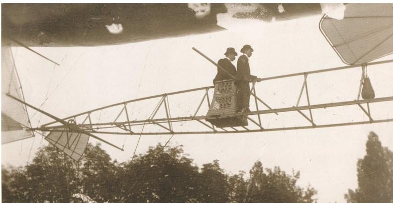
Fig.2- Uso de viga treliçada autotencionada no dirigível nº5.
