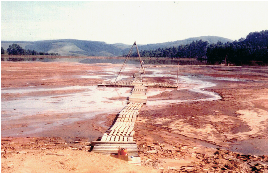
FIGURA 7.12: Estação de Trabalho em Região do Reservatório Não Navegável
