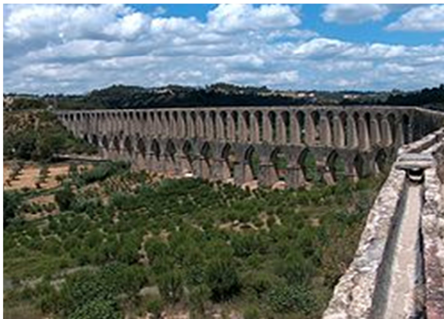
Figura 3 – Aqueduto dos Pegões, em Portugal Fonte: http://pt.wikipedia.org (2012).
