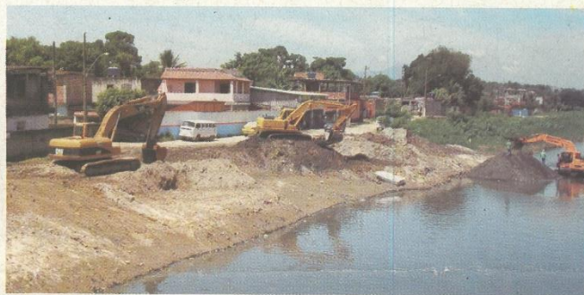
Obras do Projeto Iguaçu no Rio Botas, Belford roxo.
