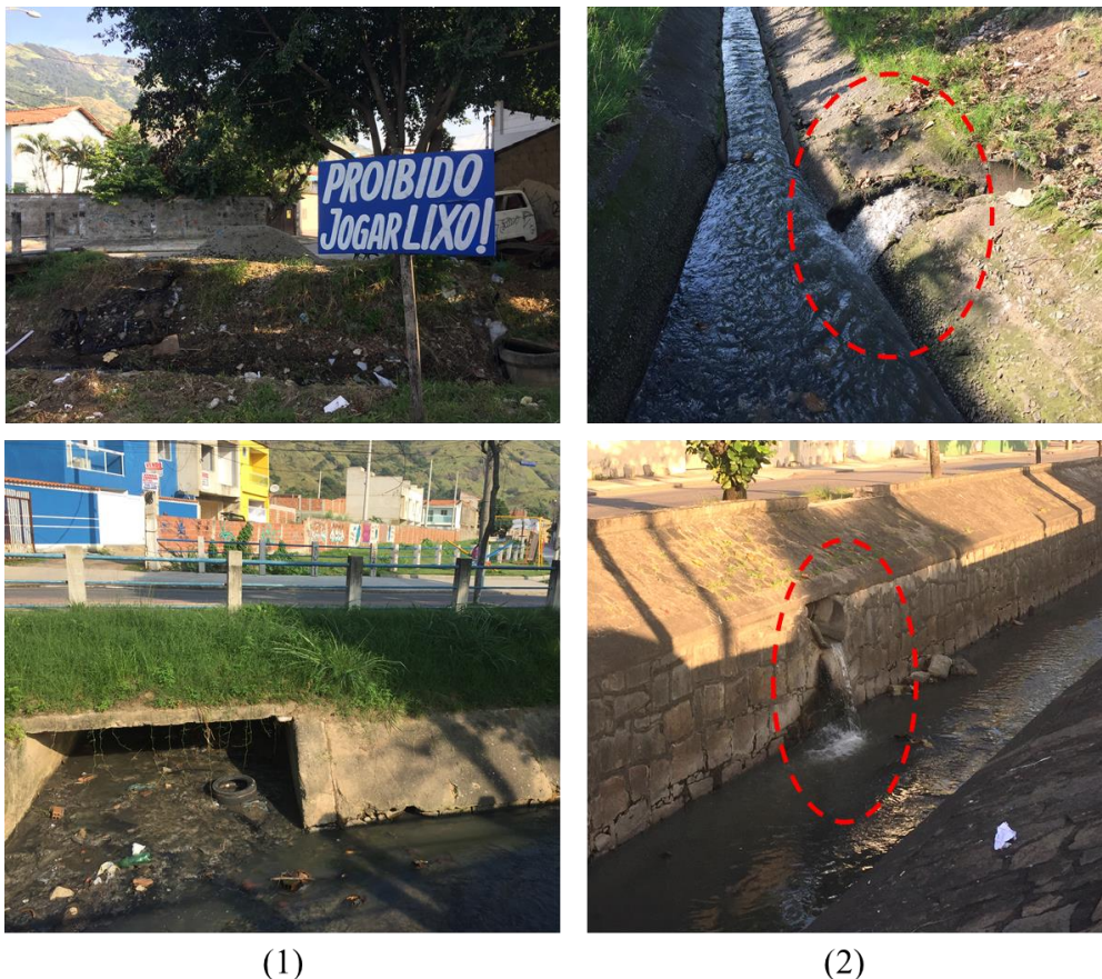
Figura 44 - Poluição hídrica por despejo de resíduos sólidos e esgoto
