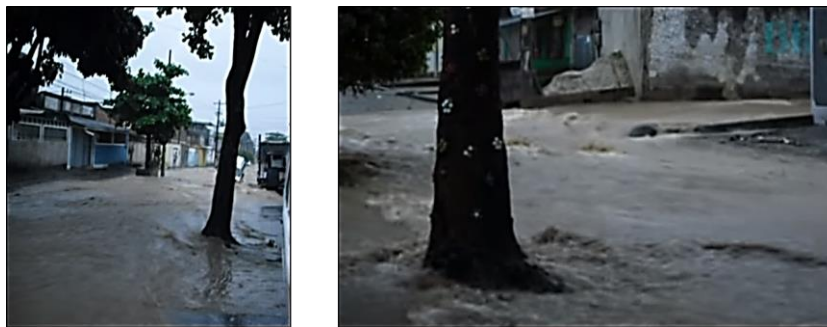
Figura 42 - Enchente na Rua Tibagi
