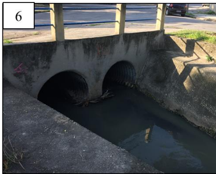
6 Rio das Tintas - Redução de seção – Rua Barão de Capanema com Rua Mongólia
