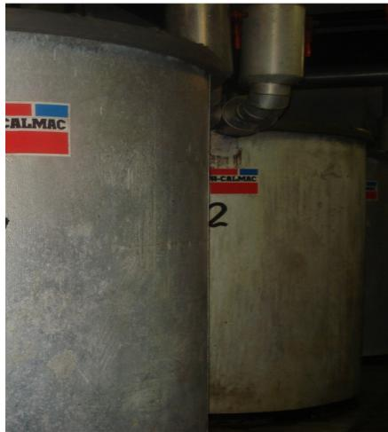
Figura 14 – Instalação típica de um reservatório de gelo
