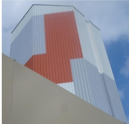
Figura 13 – Instalação típica de reservatório de água gelada
