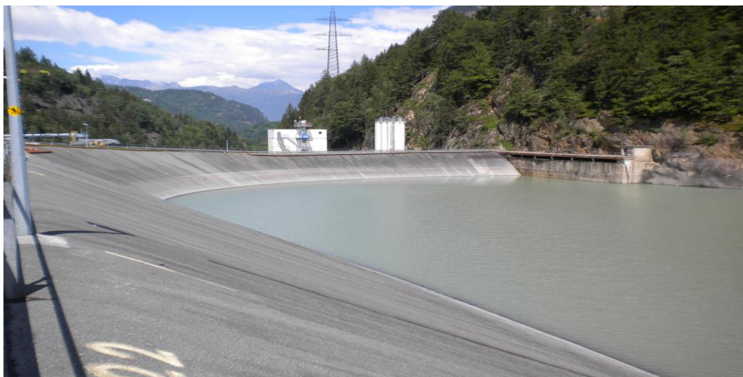
Figura 22: Reservatório superior da UHR Nante de Drance, Suíça (MELLO, 2017)
