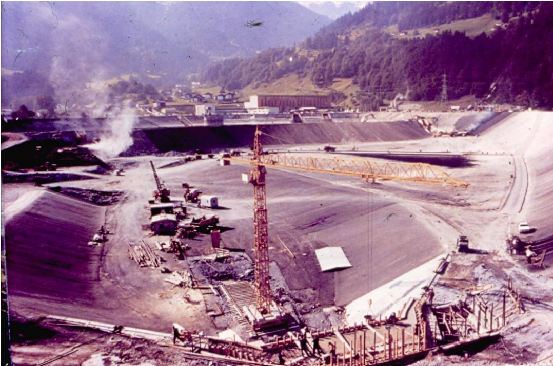
Figura 23: Execução de impermeabilização com manta asfáltica no reservatório intermediário do esquema Kölnbrein na Áustria, em 1997 (MELLO, 2017)
