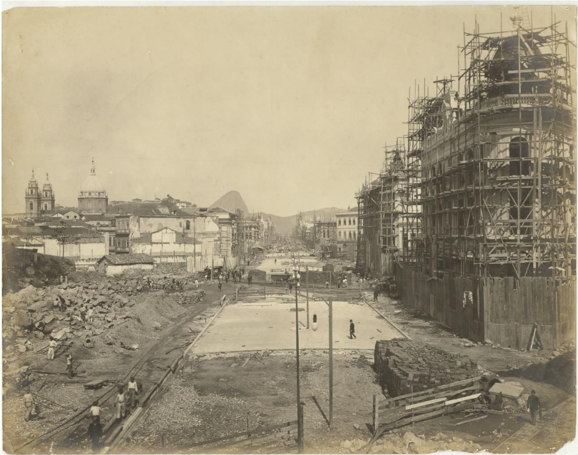
Avenida Central durante os trabalhos de pavimentação (1905). Foto: Museu da República/IBRAN/MINC (Nº de autorização 02/2018).
