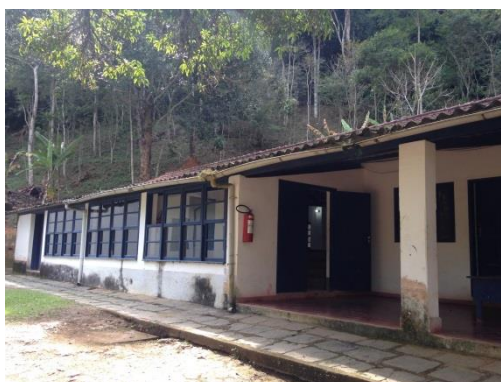
Imagem 1.2.1.e. Galpão visto de fora
