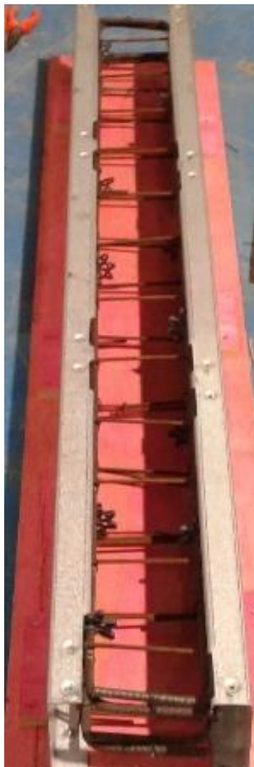
Figura 3.5 – Forma e armadura prontas para a concretagem.
