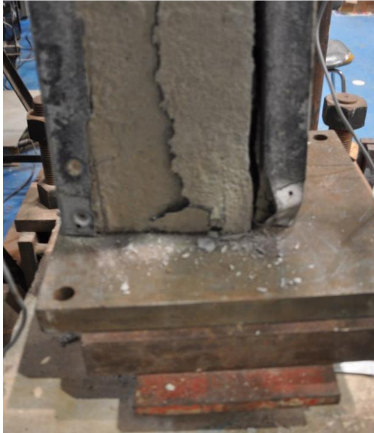
Figura 4.11 - Pilar 01 após o ensaio de compressão excêntrica.
