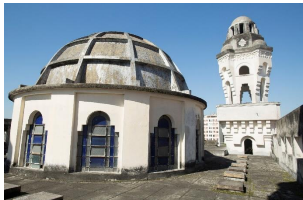
Ilustração: Foto da cobertura com a cúpula e detalhe das torres fontais.
