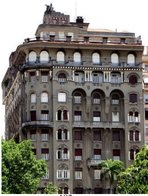
Ilustração 183 : Detalhe do coroamento da cobertura.
