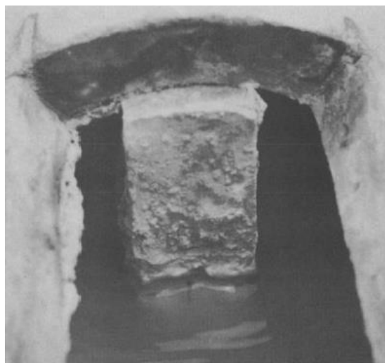
Figura 2.13 – Deterioração de amostra de argamassa imersa parcialmente em esgoto na planta de demonstração por 9 meses [32].
