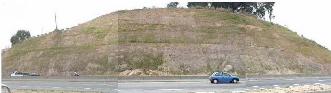
Figura 3.1 - Perfil de intemperismo de solo residual jovem localizado em talude de corte na Rodovia Washington Luís, BR 040 - km 111.
