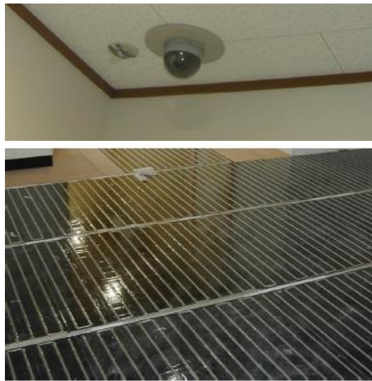
Figura 2.11 – Uso de sensores no teto e no piso da NICT Ubiquitous Home Fonte: Yamazaki. (2007).
