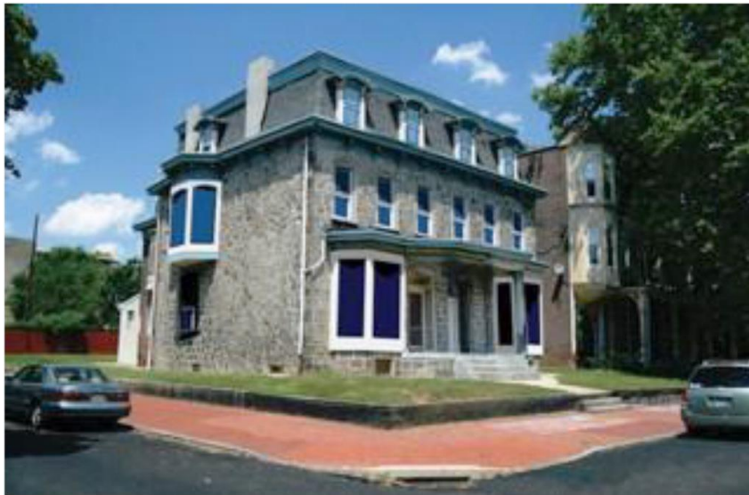
Figura 2.5 – Vista frontal da Drexel Smart House Fonte: GhaffarianHoseini et al. (2013).
