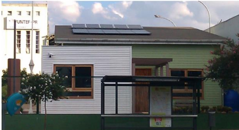
Figura 2.13 – Vista frontal do Escritório Verde da UTFPR
